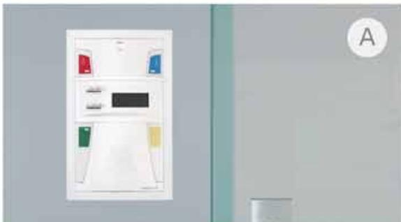
Zimmerterminal als Kommunikations-, Anzeige- und Bedieneinheit für den Pflegedienst ermöglicht zusätzlich zu den Standard-Lichtruffunktionen, mehrere programmierbare Ruf- und Anwesenheitskreise und digitale Sprachfunktionen wie Nebenabfrage und Personalsprechen.
