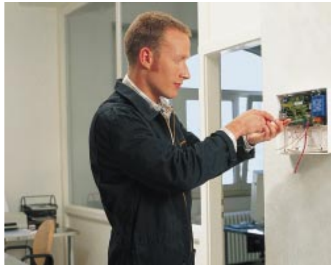
Schnelle Installation durch den Fachmann
